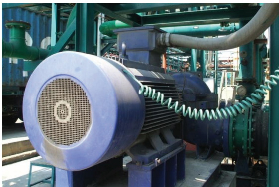
รูปที่ 12.2 มอเตอร์ของเครื่องสูบน้ำหล่อเย็นสำหรับระบายความร้อนให้ส่วนการผลิต
