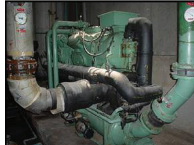
รูปที่ 11.1 2-stage Chiller เครื่องเดิม ขนาด 160 Ton ความเย็น
