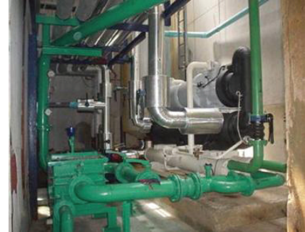
รูปที่ 11.3 Multi-stage Chiller ขนาด 160 ตันความเย็น
