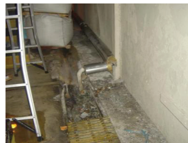
รูปที่ 17.3 หลังดำเนินการปรับปรุงโดยการติดตั้ง Steam Trap
