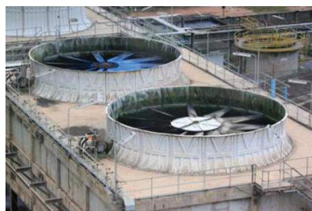
รูปที่ 14.2 ใบพัด Cooling ประสิทธิภาพสูงหลังดำเนินการปรับปรุง
