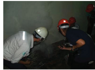
รูปที่ 17.1 การตรวจสอบจุดรั่วไหลไอน้ำ
