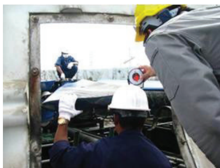
รูปที่ 14.3 เจ้าหน้าที่ดำเนินการปรับลมใบพัด Cooling ประสิทธิภาพสูง
