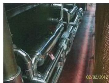
รูปที่ 18.2 การหุ้มฉนวน ที่ท่อไอน้ำตูบใหม่
