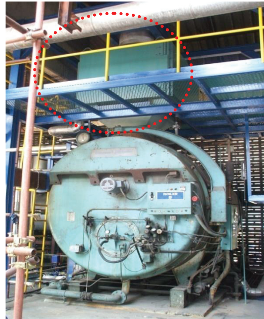
รูปที่ 19.3 การติดตั้ง ECONOMIZER ของโรงงาน
