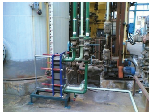
รูปที่ 1.2 Plate heat exchanger และระบบท่อน้ำคอนเดนเสทที่ใช้ในกระบวนการผลิต
